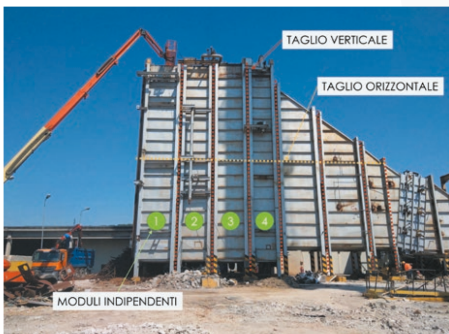
Individuazione degli elementi oggetto di intervento di bonifica mediante smontaggio e posizionamento a terra
