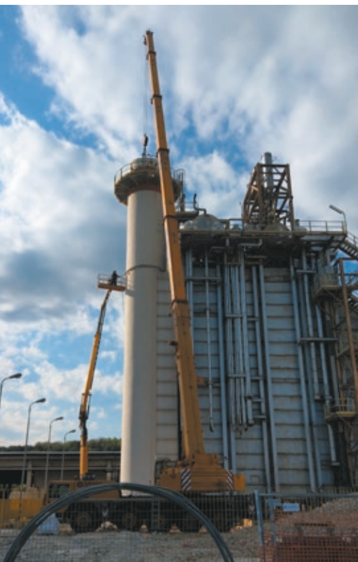
Decostruzione del camino terminale del generatore a vapore a recupero
