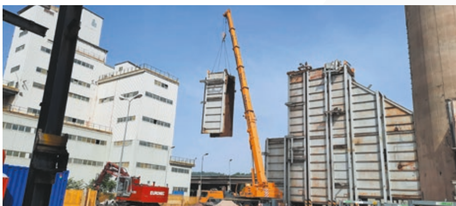
Decostruzione dei moduli costituenti il generatore a vapore a recupero
